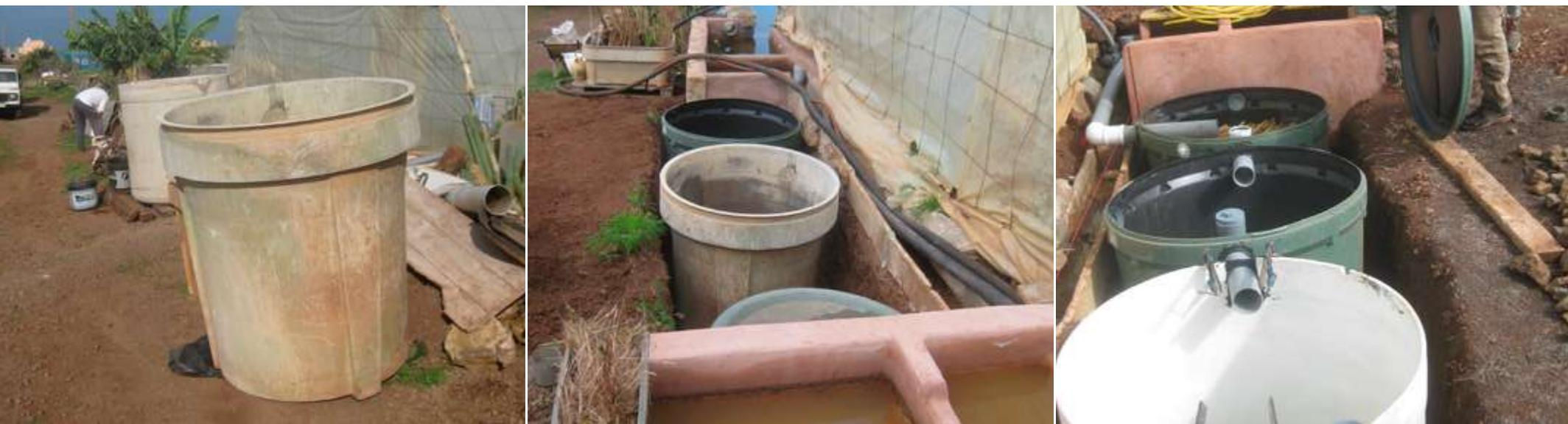
El primer recipiente hace de digestor de grasas, de salinidad y materia orgánica y es el más cercano al efluente del saneamiento. El tubo del efluente entra en el recipiente por la parte superior, a nivel de superficie.
